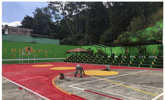
REMOZAMIENTO CANCHA DEPORTIVA Y PARQUE DEL SECTOR 3 DE VILLA HERMOSA 1
