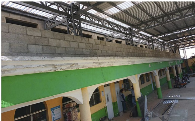
MEJORAMIENTO DE ESCUELA PRIMARIA VICTOR MANUEL MORAGA ZONA 1
