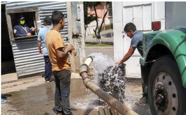
POZO ZONA 1 (BODEGA MUNICIPAL)
